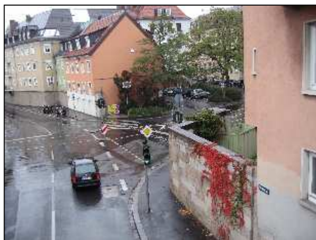
メイン川の氾濫に備え、堤防の役割を持つ1階部分
