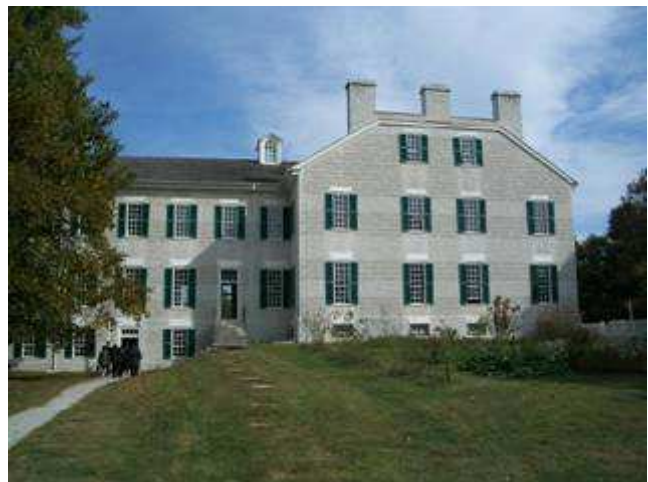
シェーカーの住んでいた建物
