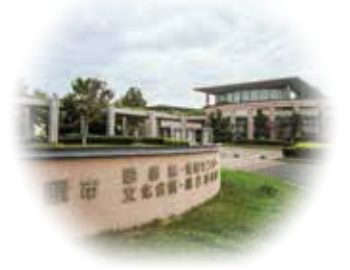
教育費 32億6396万円 田原文化広場整備事業 (田原文化会館多目的ホール非構造部材耐震改修工事) 3213万円
