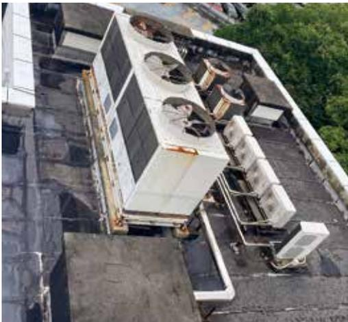
市役所北庁舎の空調設備は、老朽化によって故障が発生しており、設置から40年経過した現在、部品確保ができないなど修繕対応が困難であるため、更新工事を行います。事務室内の工事は閉庁日に行うため、窓口サービスに支障はありません。
